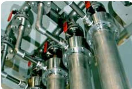
Das Rohbiogas enthält zunächst zwischen 48 und 65 % Methan ( $\text{CH}_4$ ) sowie 35 bis 52 % Kohlendioxid ( $\text{CO}_2$ ) und geringe Anteile anderer Spurengase, die als Verunreinigungen gelten. Diese müssen vor der Einspeisung in das Erdgasnetz vom Methan abgetrennt werden.
